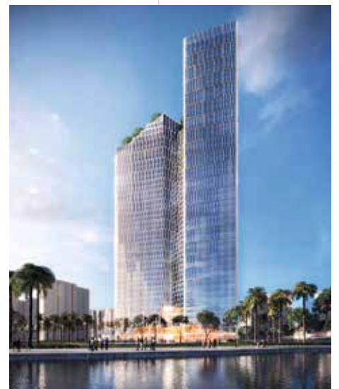
Vinfast Tower, 办公楼 河内, 越南 24台配备 PORT技术的 Schindler 7000 客户: Vingroup JSC
